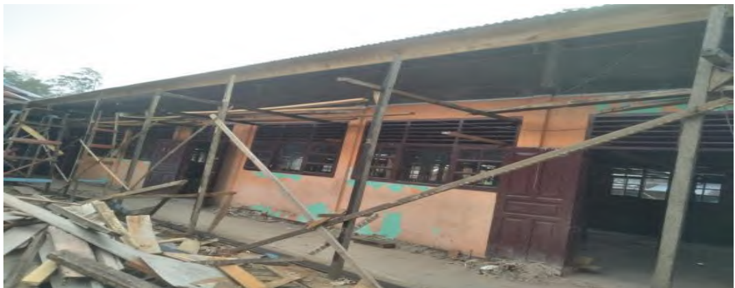
Rehabilitasi Ruang Kelas Sekolah Jenjang SMP
