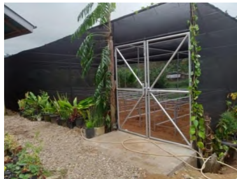
Kegiatan pembangunan screenhouse di nagari Batang barus Kec. Gunung Talang
