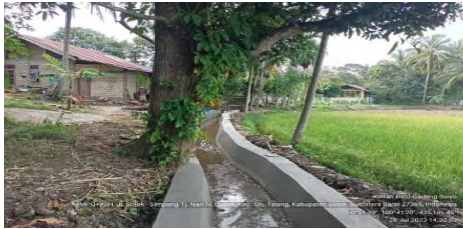
Kegiatan rehabilitasi jaringan irigasi tersier Irigasi Irigasi Sawah Nyanta di Banda Putuih Jorong Koto Kaciak Nagari Muaro Paneh Kecamatan Bukit Sundi
