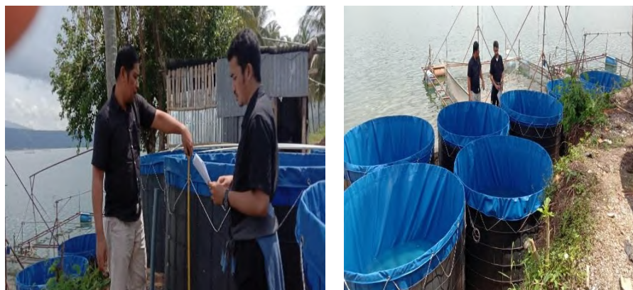
Pembuatan Kolam Terpal di Pokdakan Anugerah Nagari Muaro Pingai
