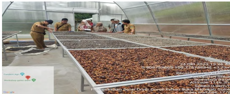
Bangunan solar dryer dome di kelompok tani sukamaju nagari Sirukam kec. Payung Sekaki
