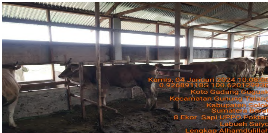
Pembangunan UPPO di Kec. Gunung Talang
