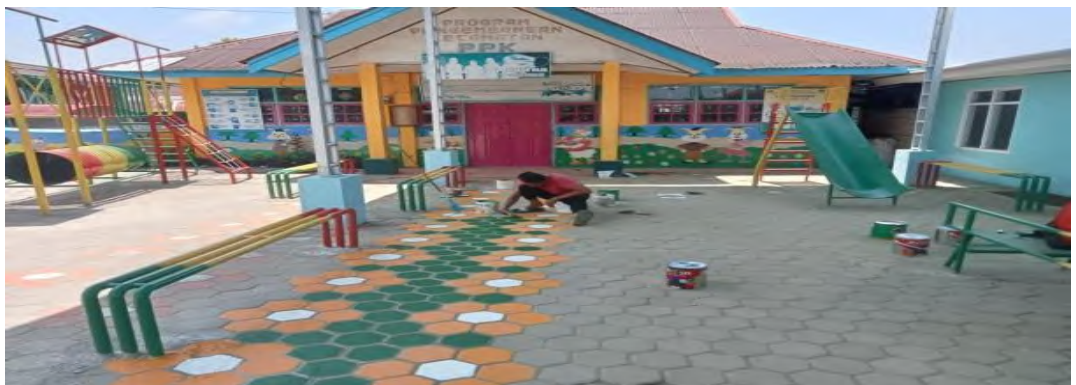
Pembangunan Sarana (APE) bagi lembaga PAUD
